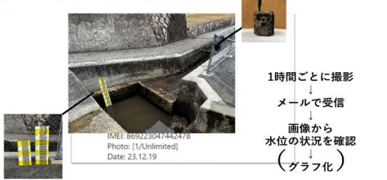
図-4 モニタリングの機材
